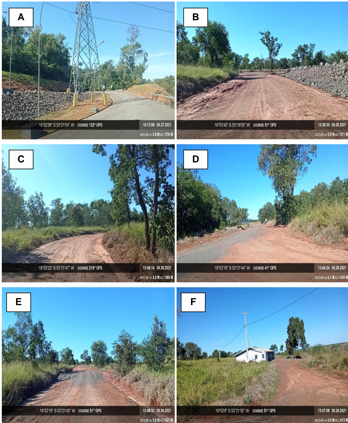
Figura 8 – Estradas de acesso interno da PCH Verde 4A: (A) acesso a casa de força; (B) acesso a margem esquerda do barramento; (C) acesso ao barramento; (D) acesso a guarita e portão; (E - F) acesso ao centro de reprodução de peixes. Município de Água Clara/MS. Campanha de maio de 2021.
