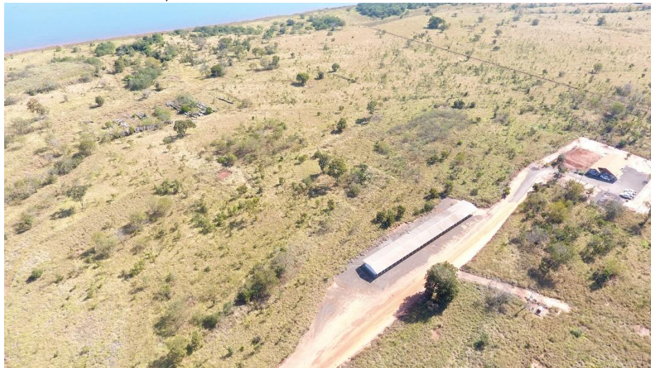
Figura 8. Imagem aérea e terrestre da área do antigo bloco dos alojamentos operacionais (indicação traço). PRADE - PCH Verde 4A, maio de 2021.
